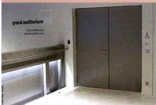
Bloc-porte "Pyroplus 60" double vantaux de chez Doortal avec classement EI60 + acoustique 51 dB + coefficient U 1.3 W/m².K et contrôle d'accès
