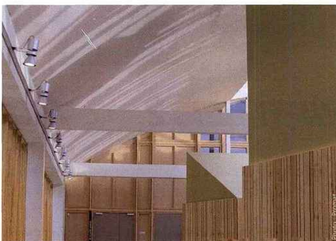
▲ La contrainte majeure consistait à veiller à ce que les produits utilisés n'alourdissent pas le poids structurel de la voûte.
