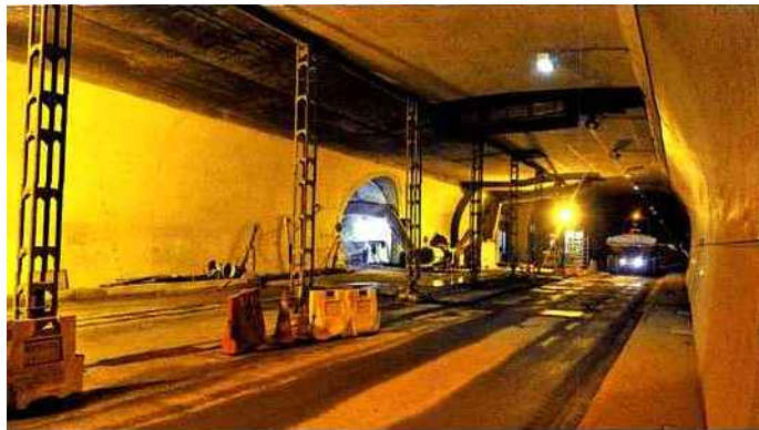
Le tunnel de Puymorens dans les Pyrénées était en travaux depuis 2013.
