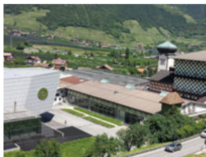
Lagundo (BZ): Stabilimento birreria FORST
