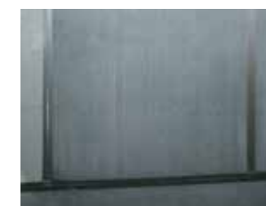
Vindspærren forseglet med tape
